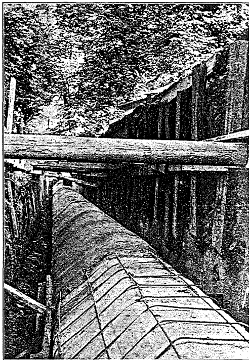
Varmeledning under Udførelse. Pudslaget over Cellebetonen paaføres.
