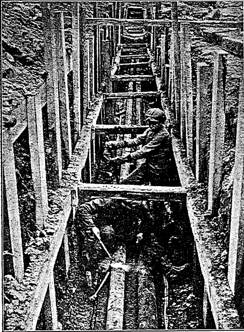
Varmeledning under Udførelse. Rørene svejses.
